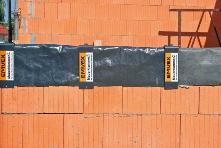
Mauerwerk im Bauzustand: Fachgerecht abgedeckte Mauerkronen
