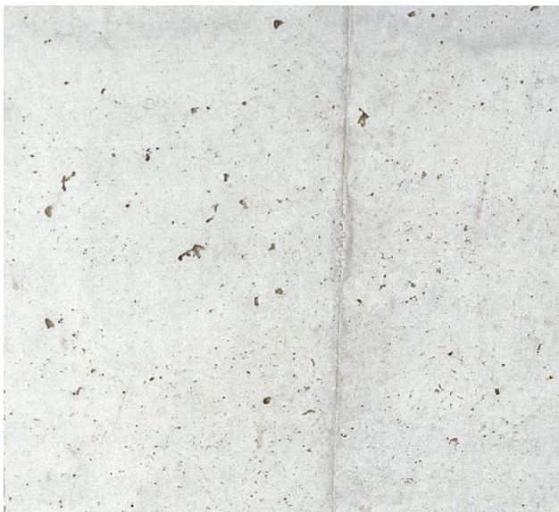
Beton mit gefügedichter Oberfläche
